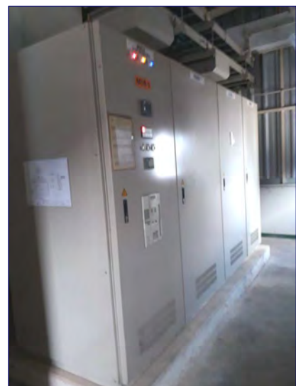
ภาพแสดงตู้เมนสวิตช์ MDB-5 (3Ø 4W 400/230V 50Hz.)
